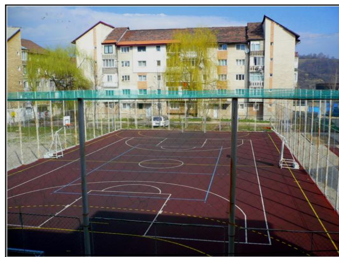
TEREN DE SPORT ÎMPREJMUIT CU GARD ȘI ACOPERIT CU TARTAN
